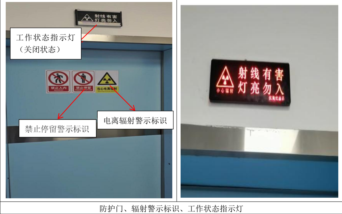
图 3-5 DSA 机房防护门处防护情况
